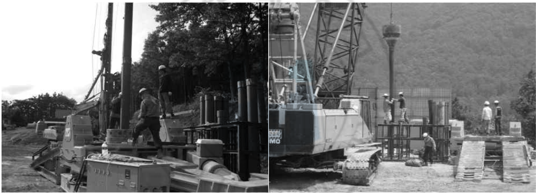
그림 3.10 트레미 파이프 설치
