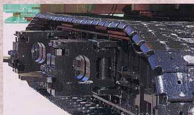
▲クローラ拡張作業中
